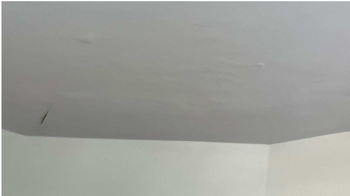
FIGURE 30 – File : allpdf/IMG_1758.pdf, plafond SAM vu de la fenêtre, 1 août
