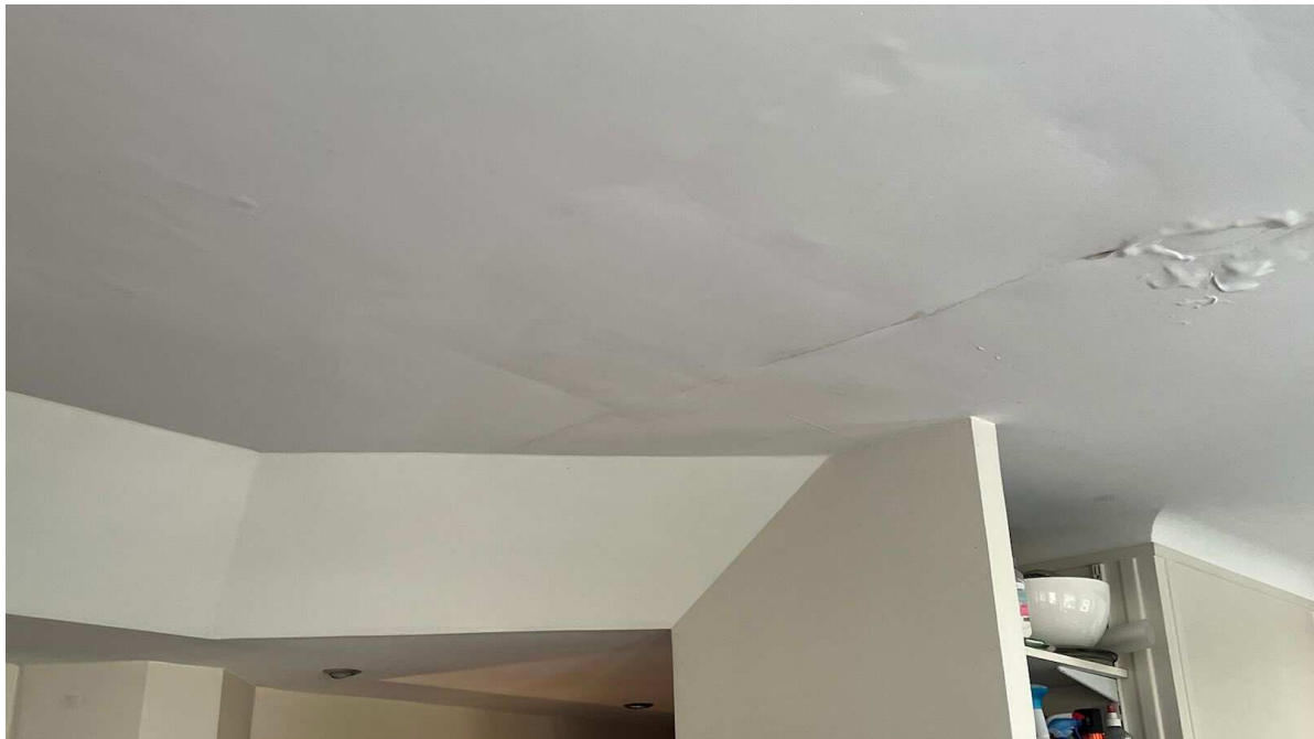
FIGURE 31 – File : allpdf/IMG_1759.pdf , plafond SAM-cuisine vu de la fenêtre, 1 août
