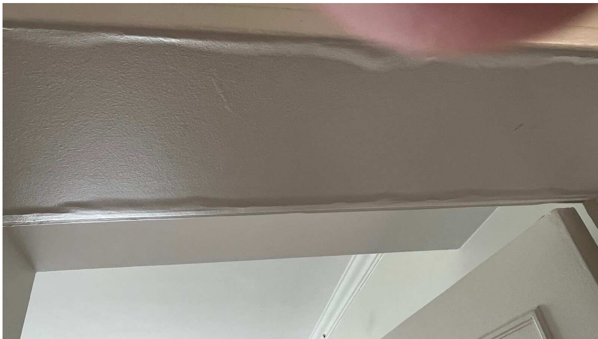
FIGURE 44 – File : allpdf/IMG_1775.pdf , haut de l'entrée chambre 1, vue vers le haut, 1 août
